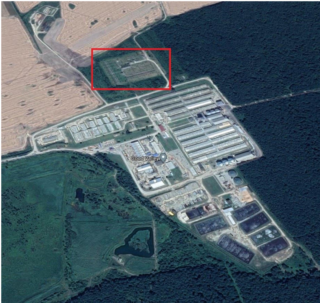
Рис. 1 – Місцезнаходження підстанції 220 кВ «Калуш»
