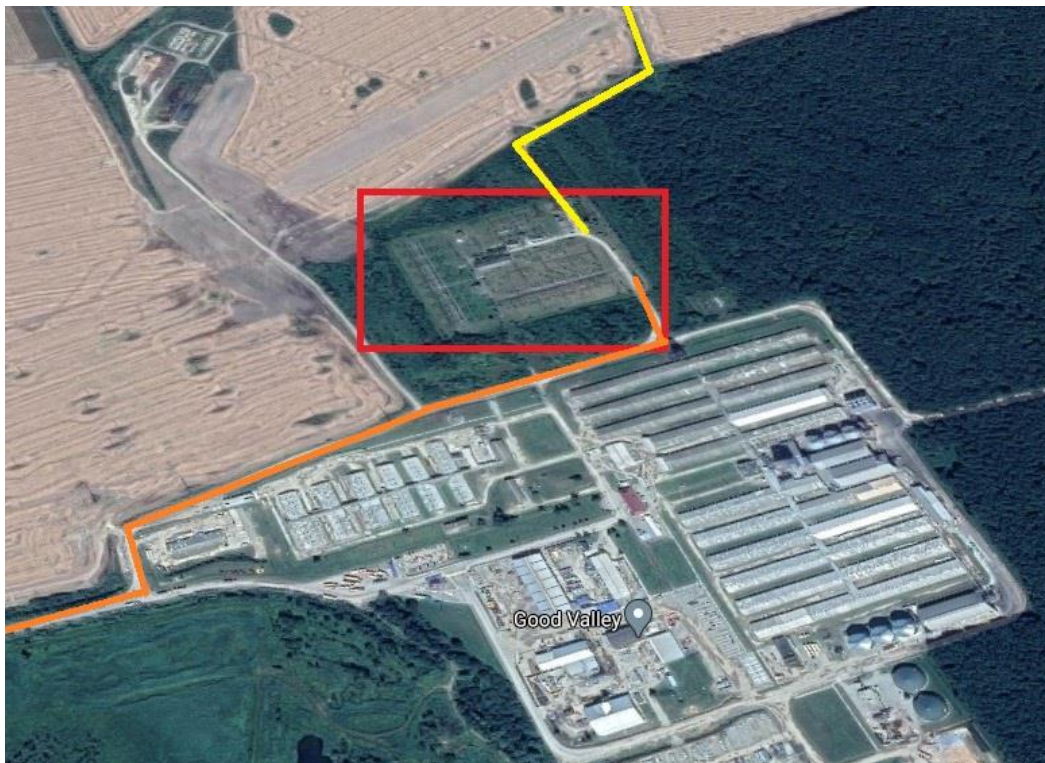
Рис.2 – Під'їзні дороги до підстанції
